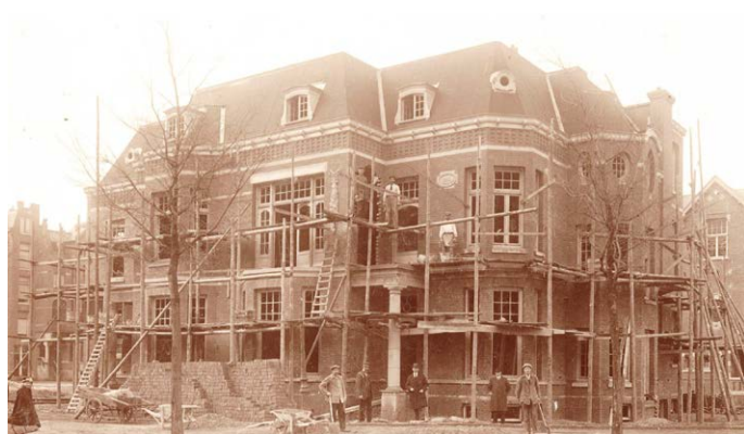
Het gebouw in aanbouw in 1918
